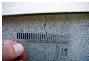
基礎のひび割れ幅が過大でないか確認
