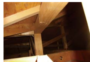
小屋裏の状況確認
